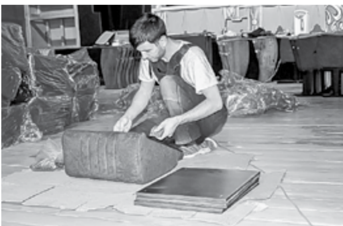
В театральном зале монтируют новые кресла-трансформеры.
