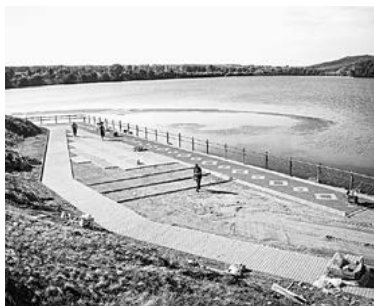
Работы на новой набережной сегодня завершены.
