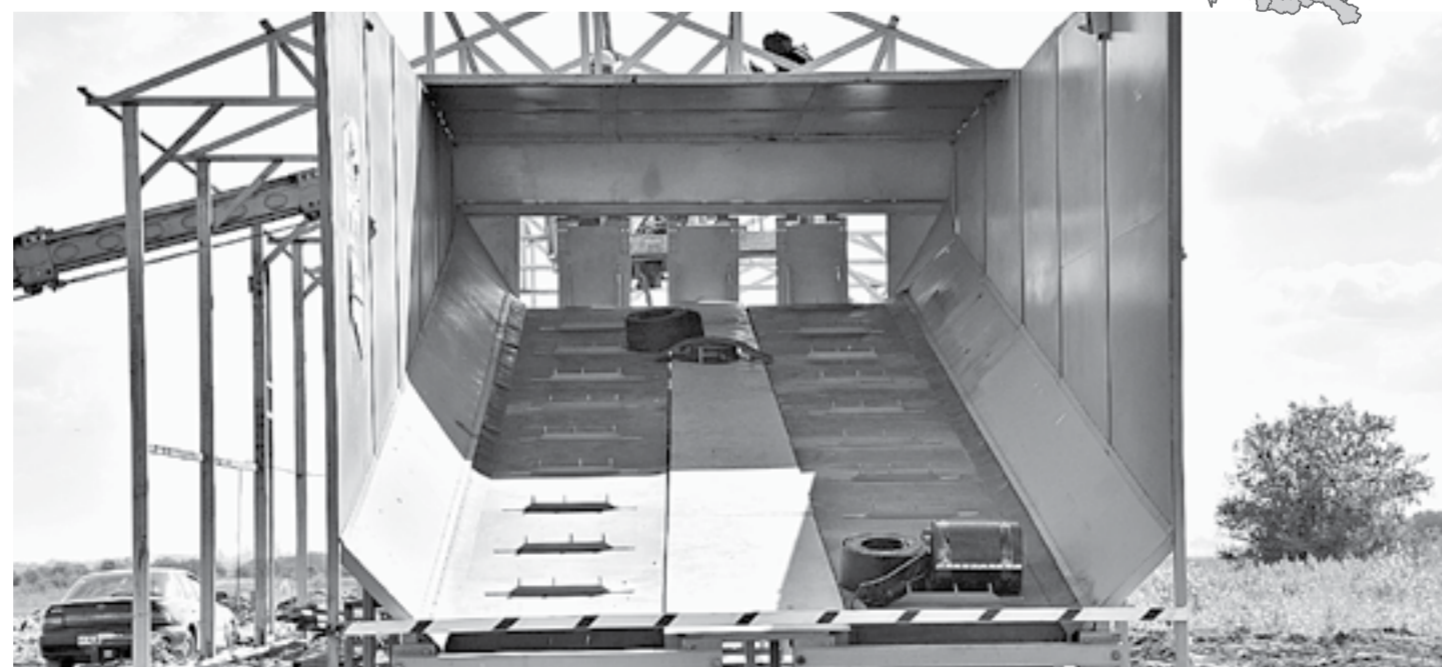
Идет монтаж нового комплекса.
