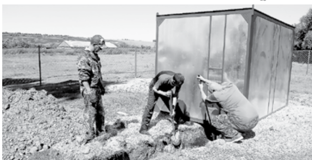
Работники местного коммунального предприятия подключают трубу к скважине.
