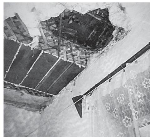
На первом этаже аварийного дома стнули все балки, на втором — все несущие конструкции.
