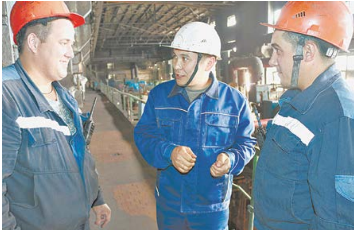
Работники яровской ТЭЦ обсуждают ход ремонтов на станции.
