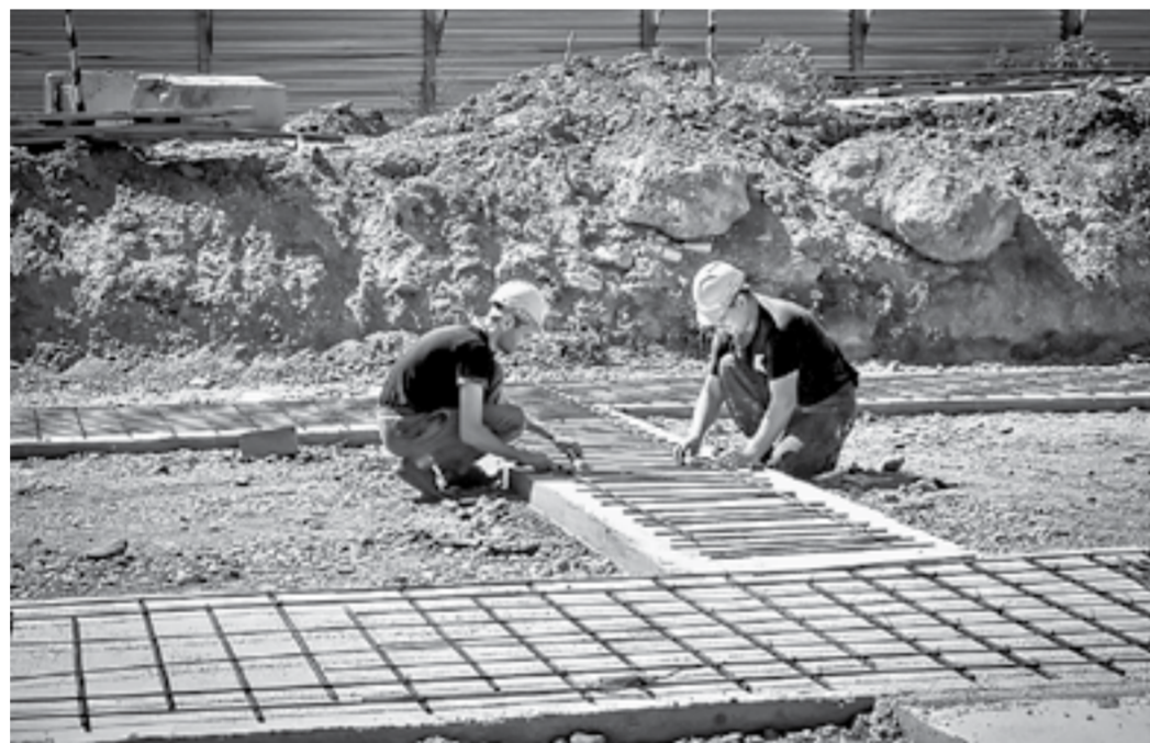
На данном этапе строительства проводятся бетонные работы.
