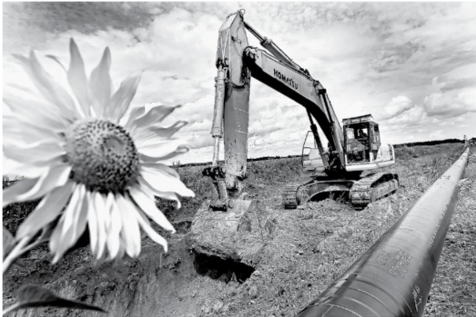
Укладку трубопровода начинают после соединения труб длиной 1,5 км.
