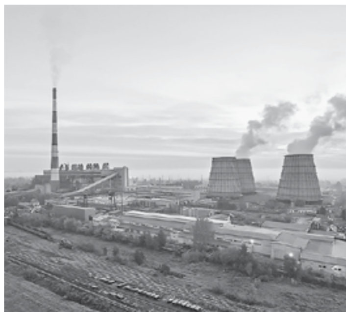
ТЭЦ-3 снабжает большинство барнаульцев горячей водой.
