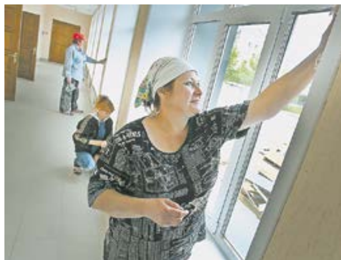
Внутренняя отделка помещений близится к завершению.
