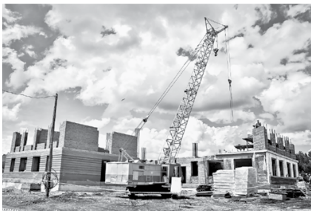
Закончить строительство планируется до Нового года, сдать объект – следующим летом.
