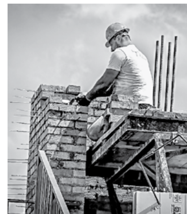
Завершается перекрытие первого этажа.
