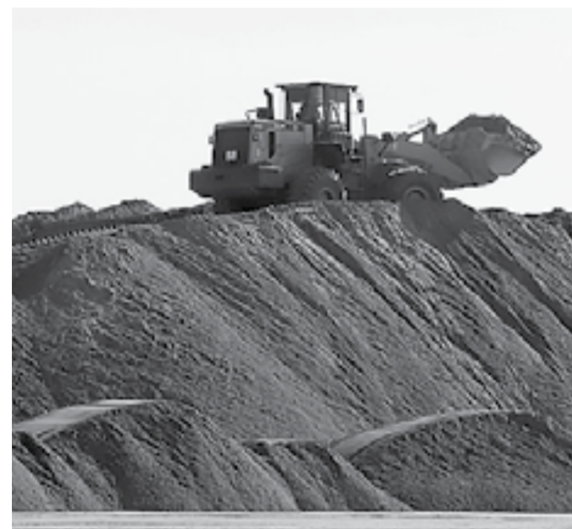
Ведется заготовка материалов для отсыпки подушки.
