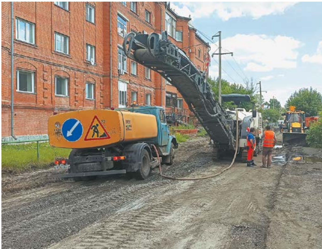
Фреза снимает остатки асфальта.
