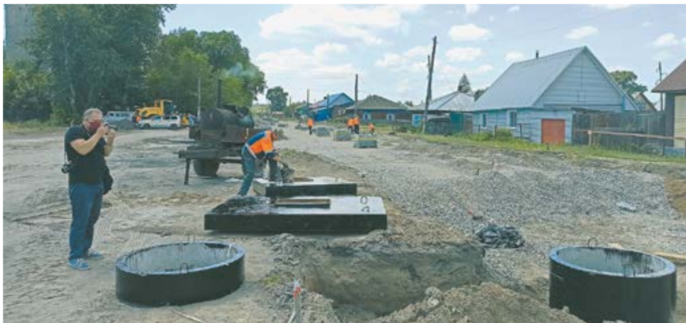
На улице Короленко для прямоты дороги пришлось выносить тепловую камеру.
