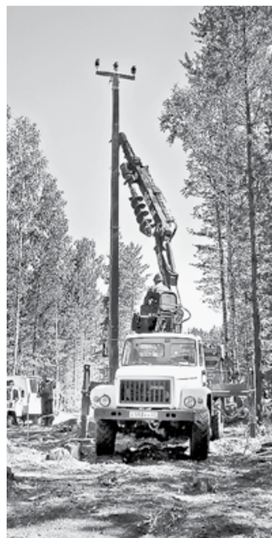
Строительство новой линии электропередачи в Смоленском районе.
