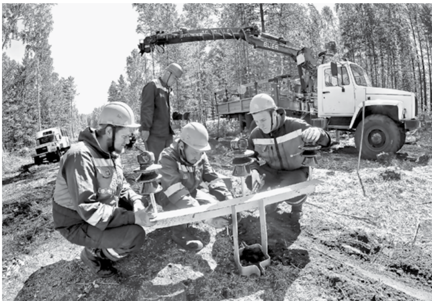
Идет монтаж опоры.
