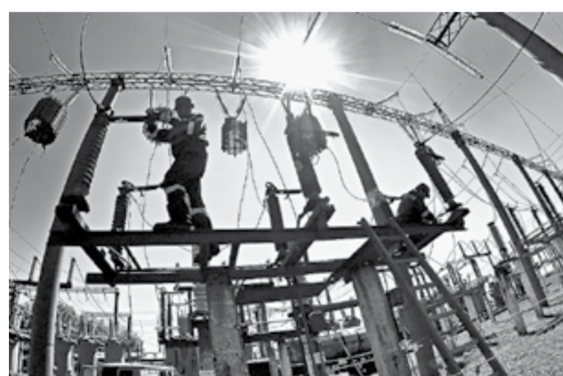
Ремонт подстанции в Смоленском.
