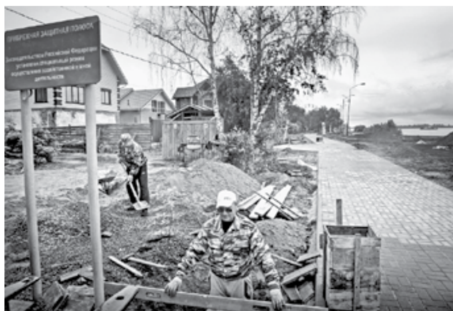
Работы идут полным ходом.
