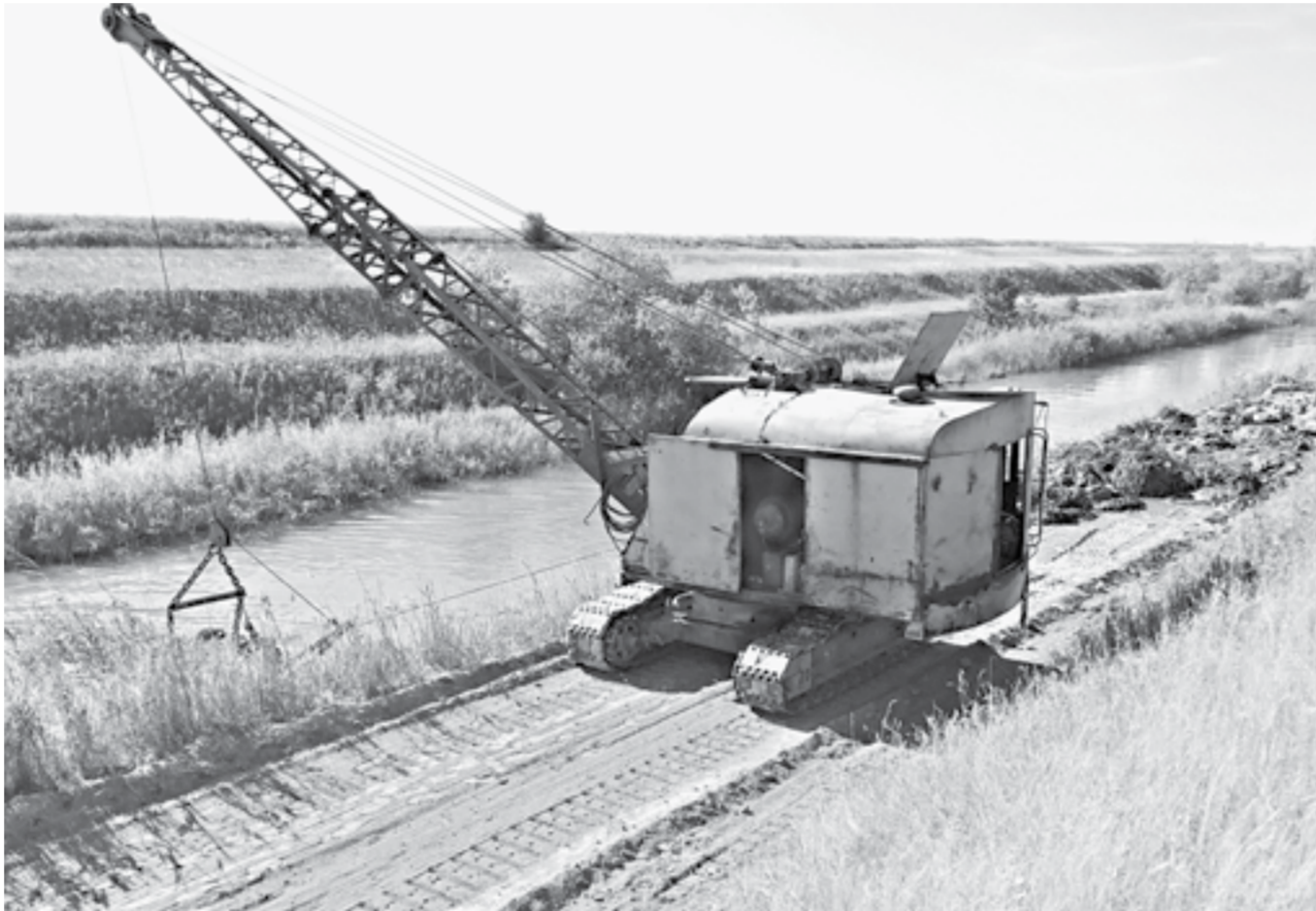
Проведение работ по очистке магистрального канала.
