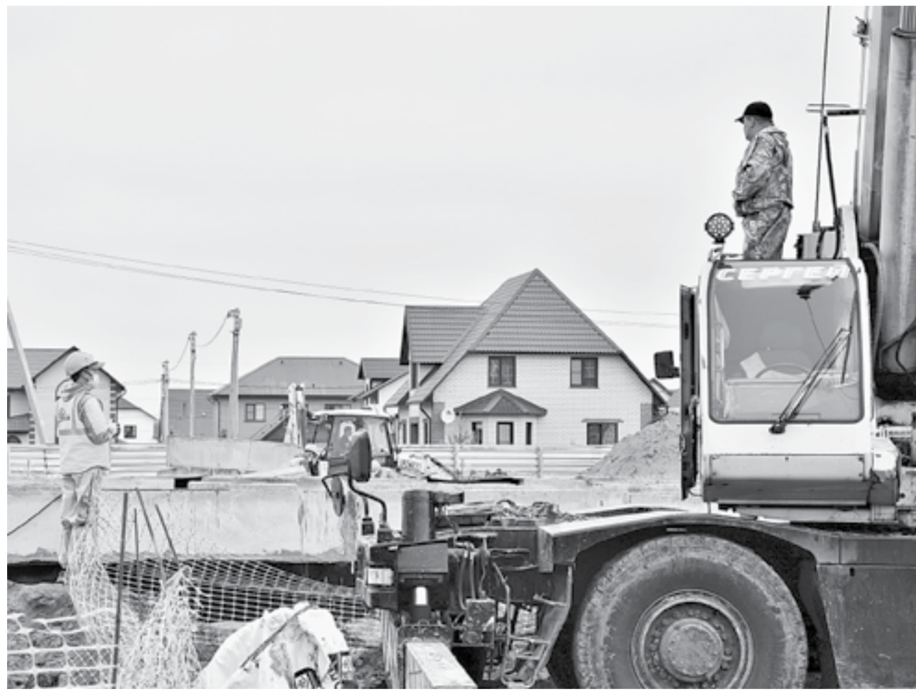
Почти завершён нулевой цикл строительства.
