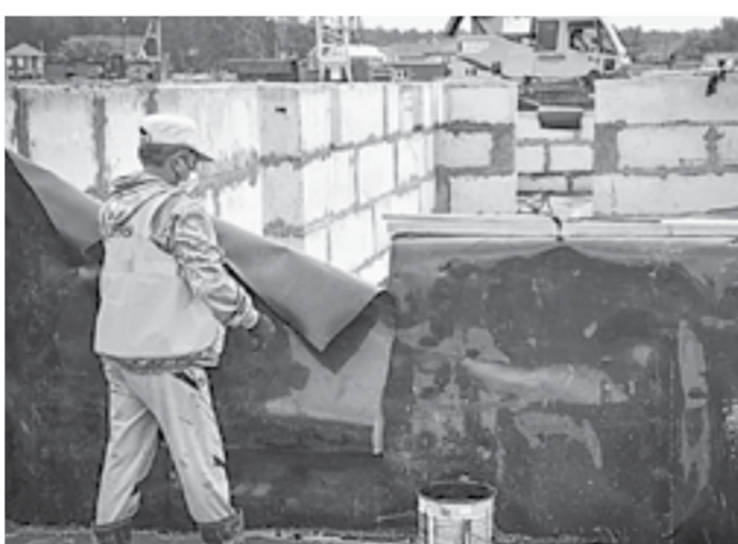
На этой неделе начнется укладка цоколя.
