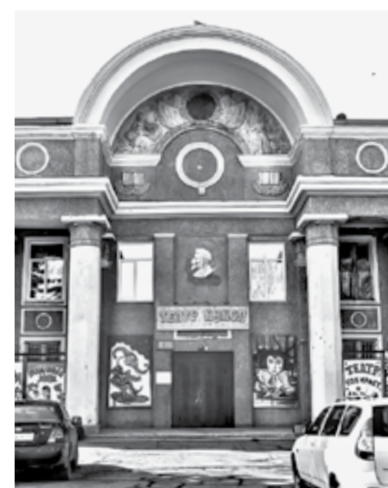
На здании кукольного театра отремонтируют крышу.
