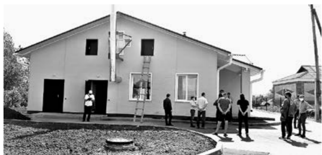
При приеме объекта серьезных нарушений выявлено не было.
