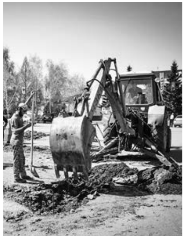
Работы по благоустройству в центре Ключей.
