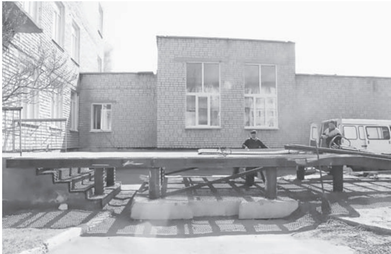
Идет монтаж подъездных путей для скорой.
