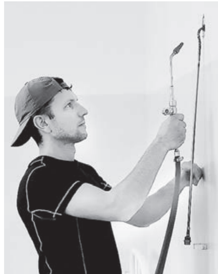
Инженер Леонид Герасимов монтирует трубу для подачи кислорода к аппарату ИВЛ.
