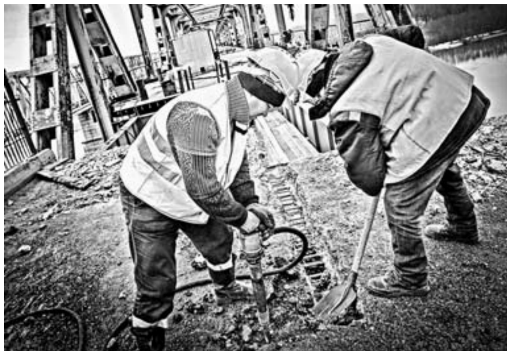
Работы по демонтажу старого покрытия.
