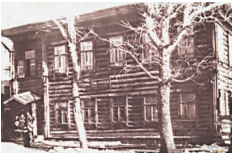
Здание на ул. Интернациональной до 1955 г.
