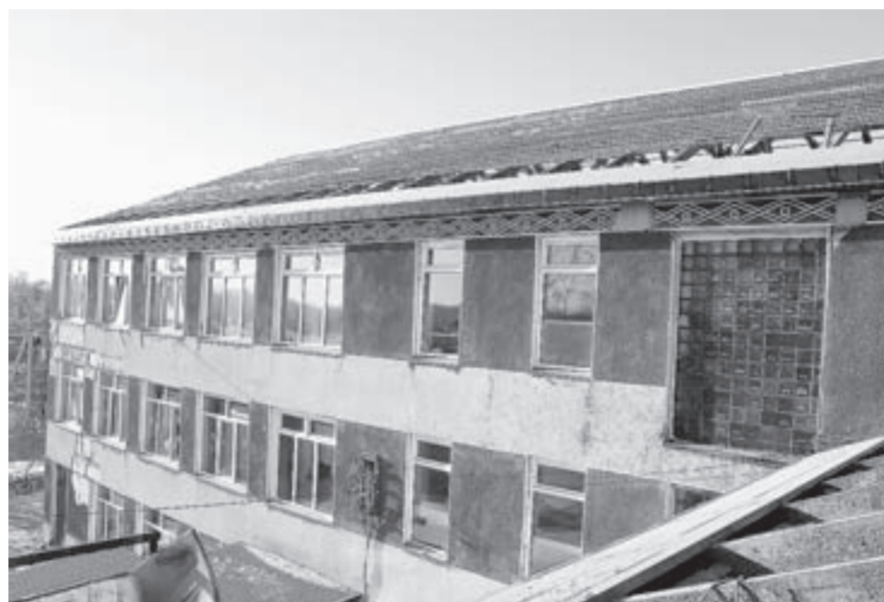
...а так она выглядела до ремонта.
