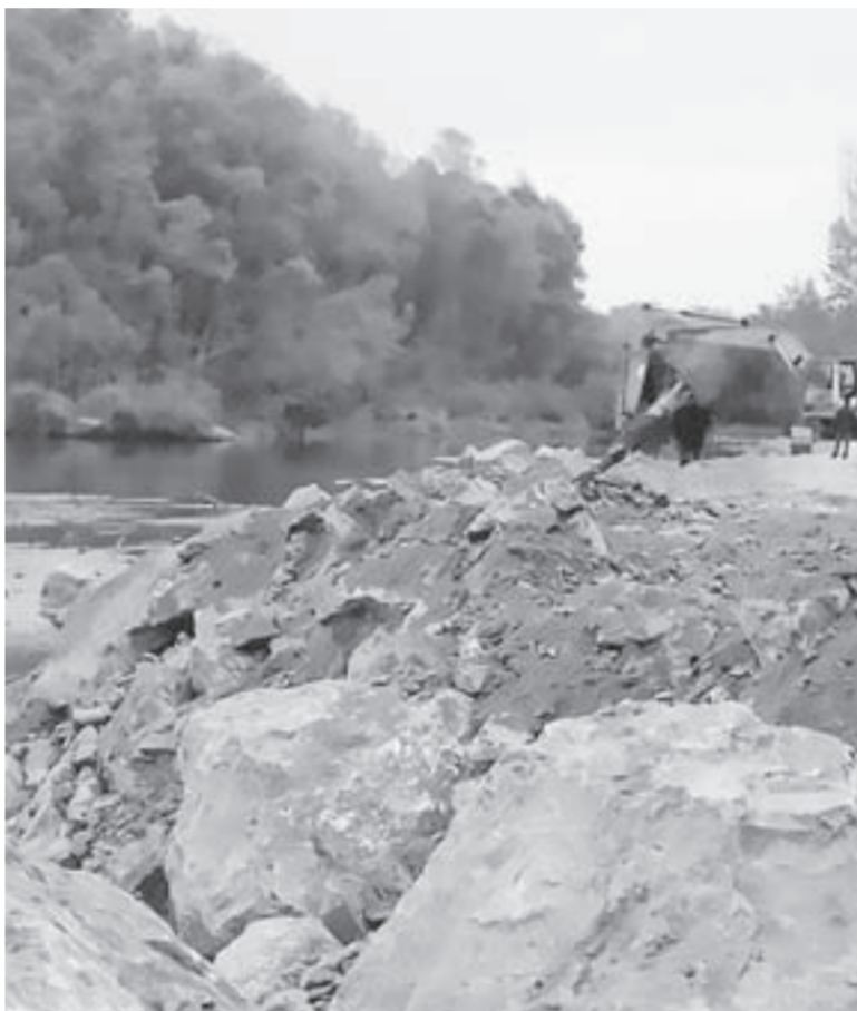
Работы по укреплению берегов проводятся ежегодно.
