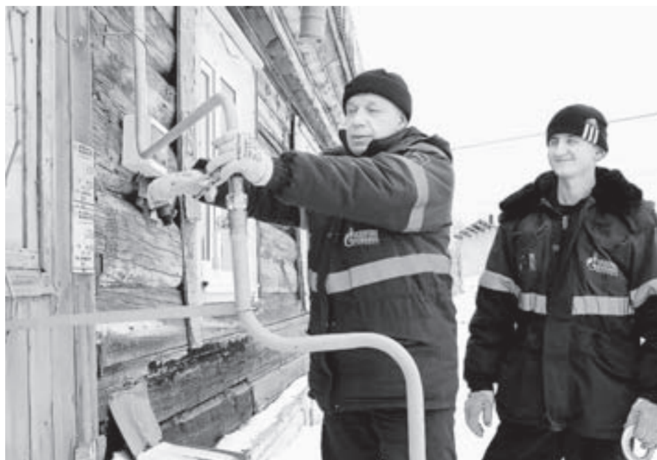
Слесарь аварийно-восстановительных работ Пётр Дума (слева) подтягивает муфты.
