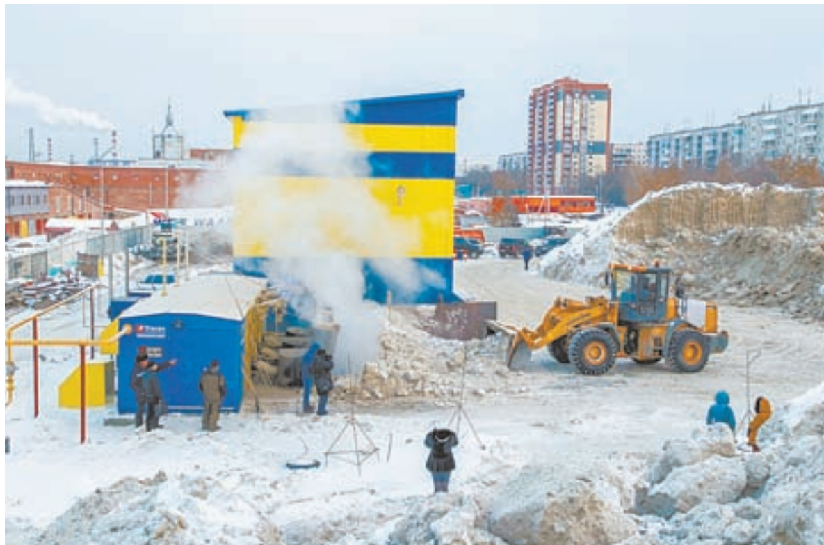
Компания «Перлит-Строй» плавит снег с помощью канадского оборудования.
