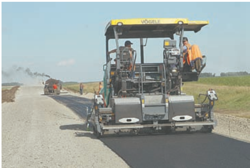
Ремонт дороги в Калманском районе.
