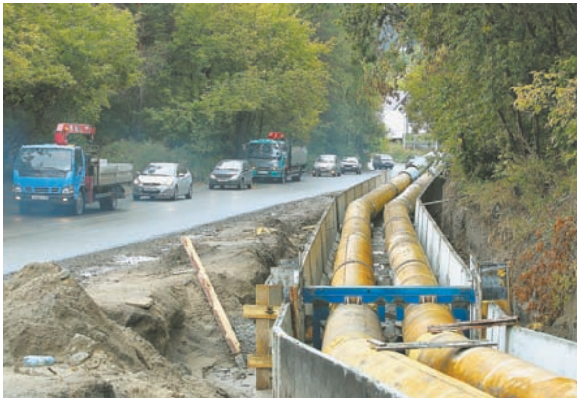
Строительство теплотрассы от ТЭЦ-3 к поселку Южному подходит к концу.
