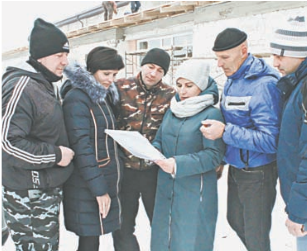
Депутат контролирует ремонт Кулундинской ДЮСШ.
