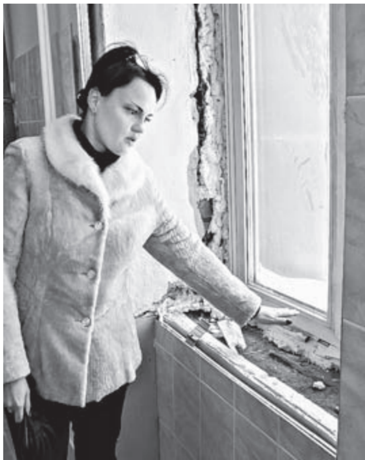
Приходится устранять недоделки по ходу работы.
