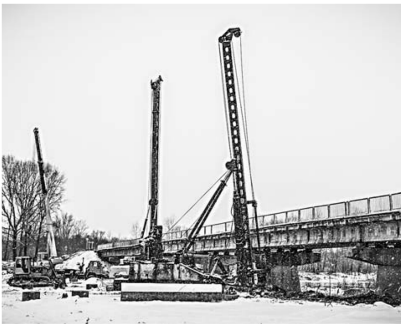
Старый мост был признан непригодным для ремонта, поэтому решили построить новый.
