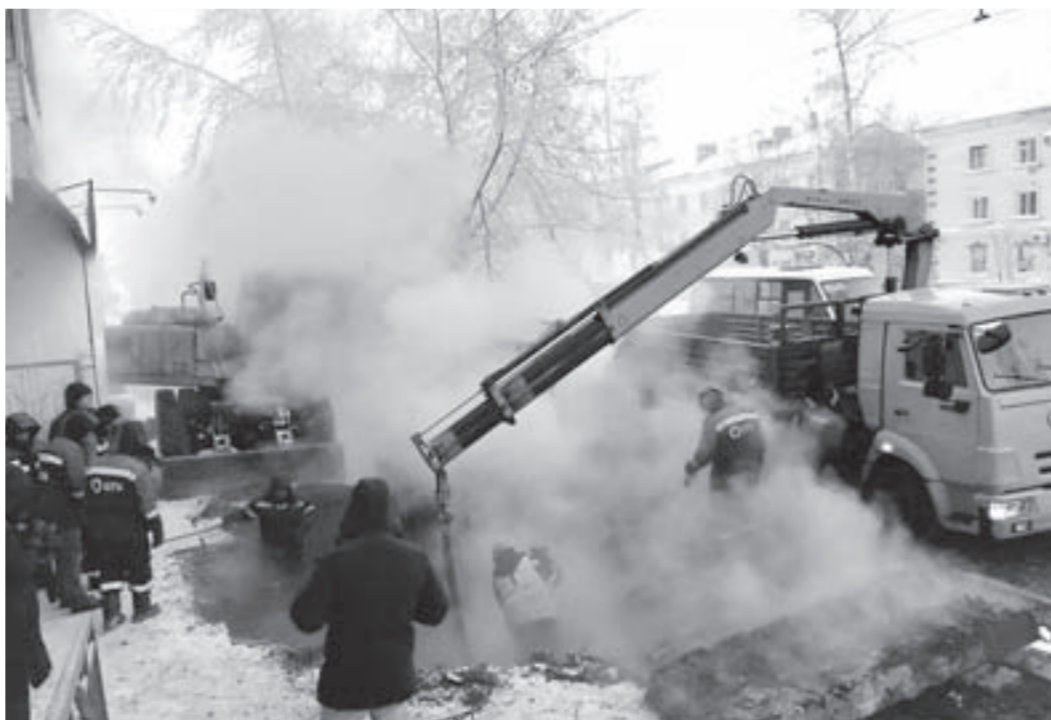
Идут работы по устранению аварии.
