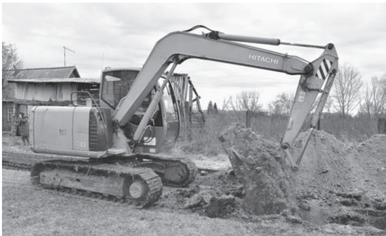
В селе Луговом ведутся подготовительные работы для укладки газопровода.
