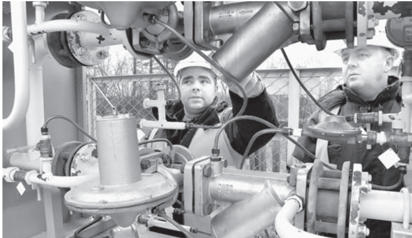
Настройка оборудования на газораспределительном пункте завершается.
