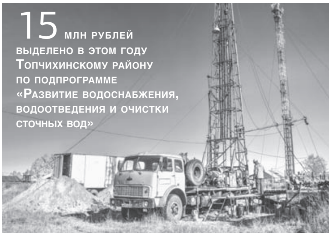
Новая скважина на Топчихинском водозаборном узле.
