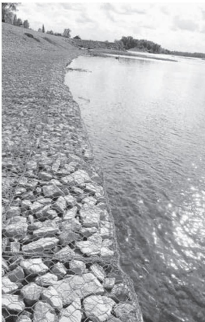
Новая дамба – это километры проволочных конструкций, заполненных отборным камнем.
