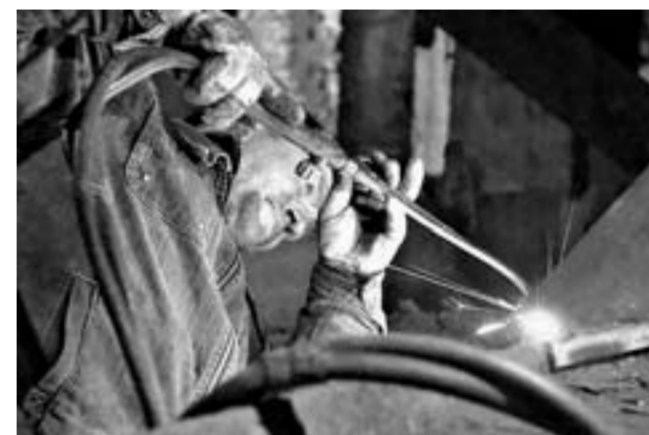
Последние штрихи: ремонт завершается.
