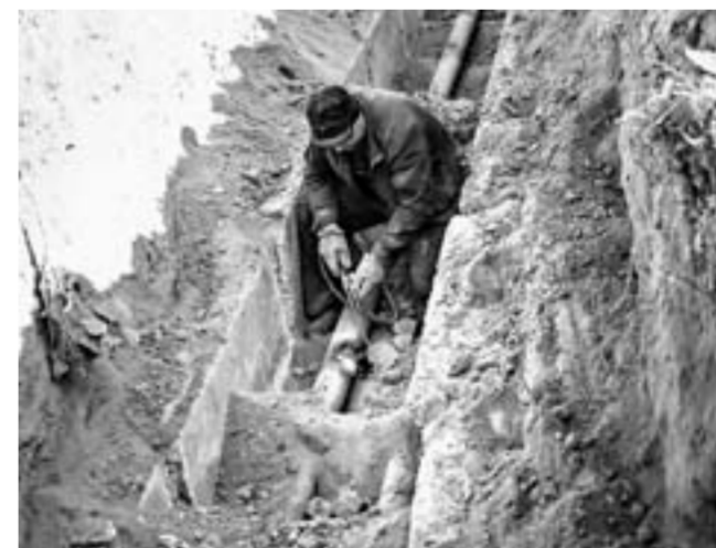
Рабочие обновляют магистраль, по которой идет тепло в новый детский сад.
