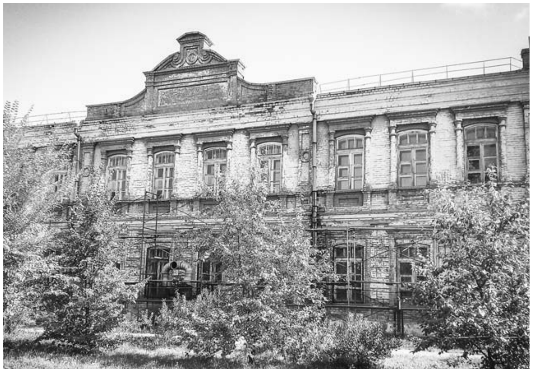
Ремонт фасада – в первую очередь.
