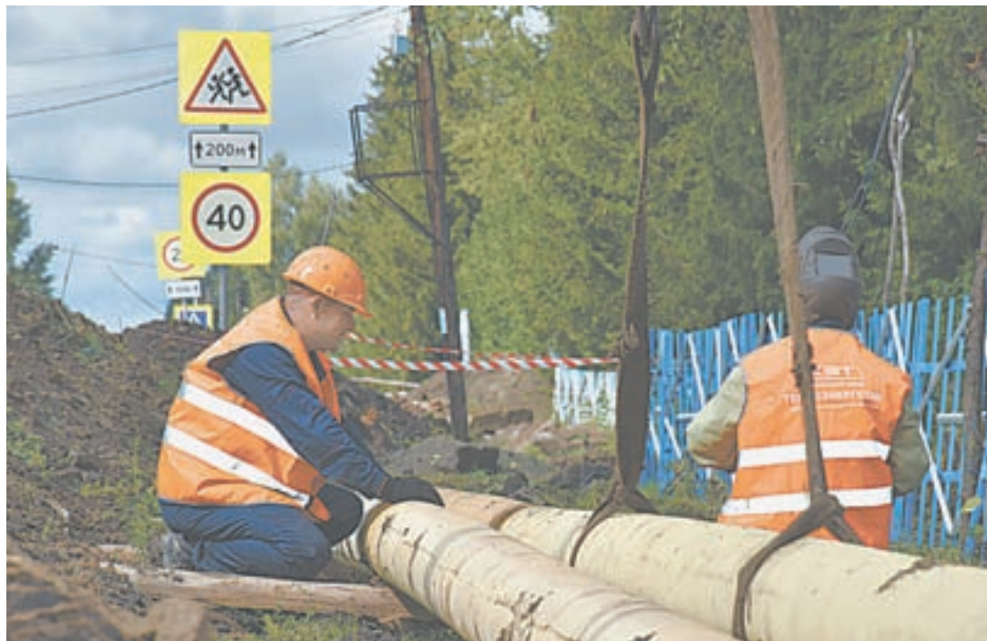
Замена сетей идет сейчас по всему краю.
