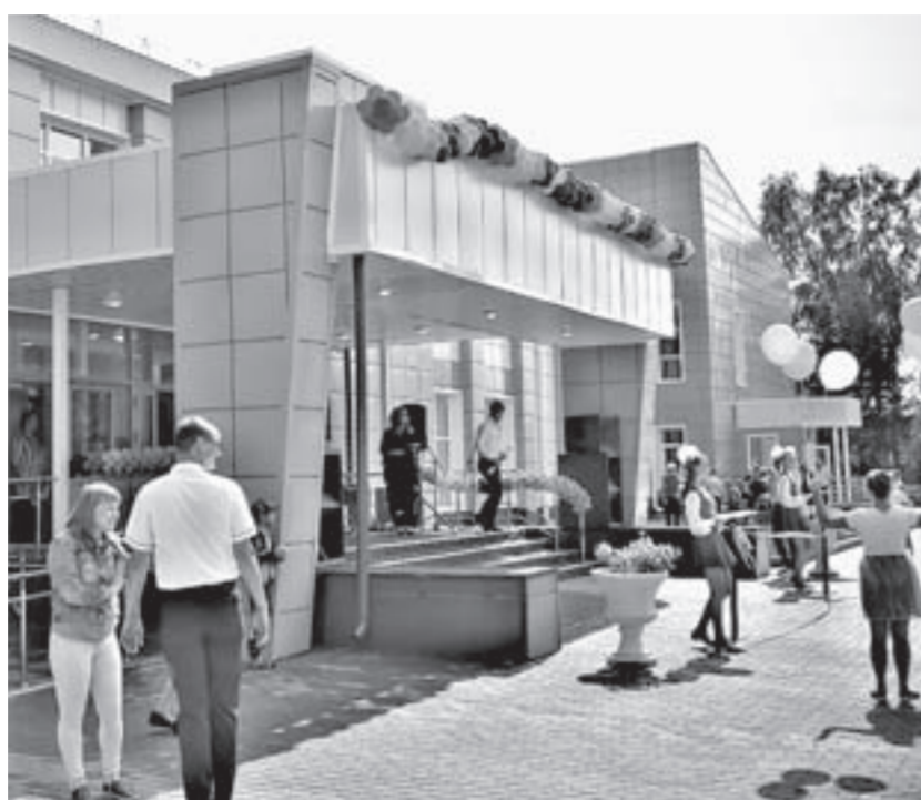
Тан выглядит здание КСК после напремонта.
