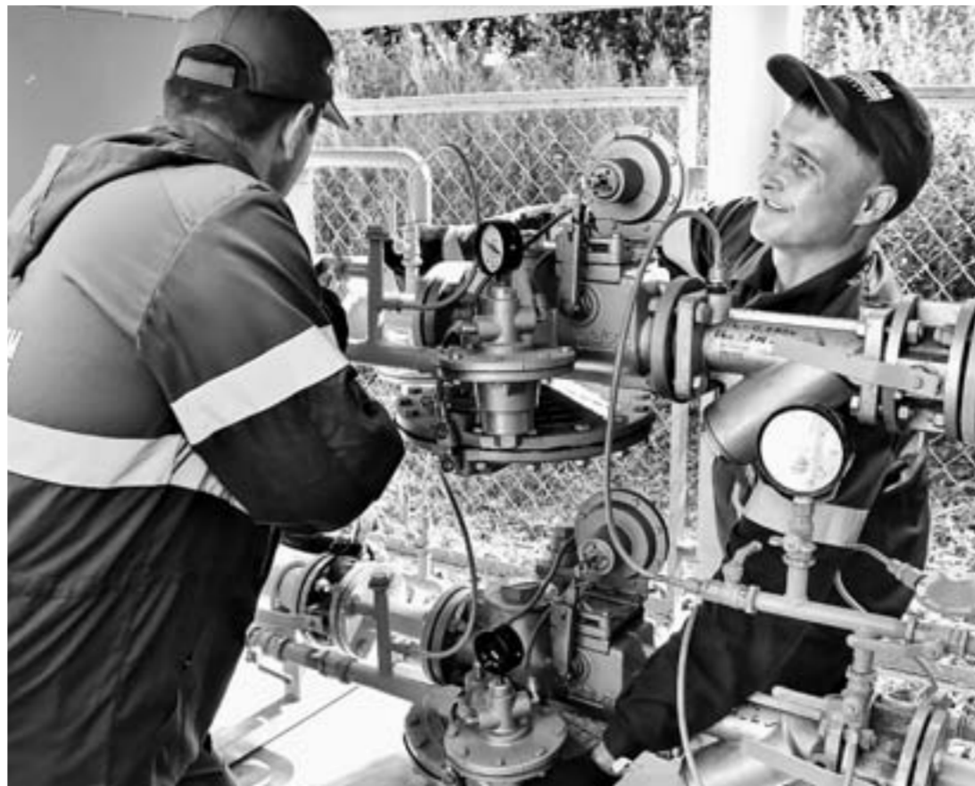
«Давление на выходе из ГРП не должно превышать 0,02 атмосферы, а если будет больше, то клапаны на газовой плите будут подпрыгивать», – смеется мастер.
