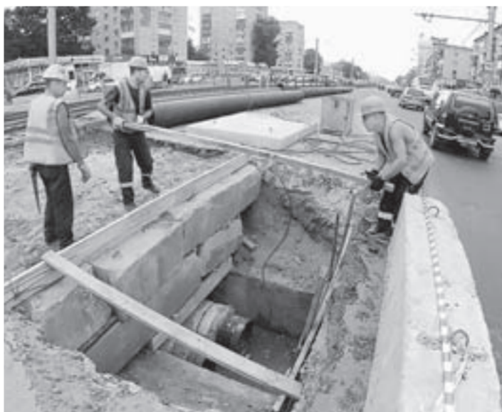
Ремонт сетей на проспекте Ленина.
