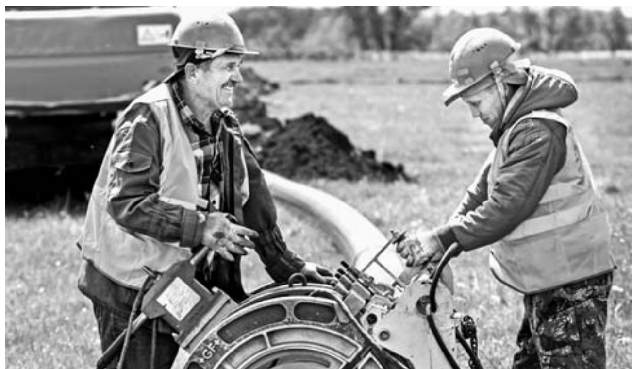
Сварщики Павел Тихе (слева) и Юрий Тумашов готовят очередной стык.
