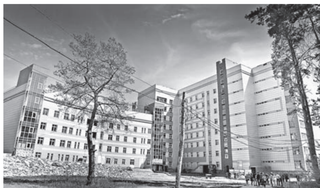
Возле долгостроя – огромная куча строительного мусора.
