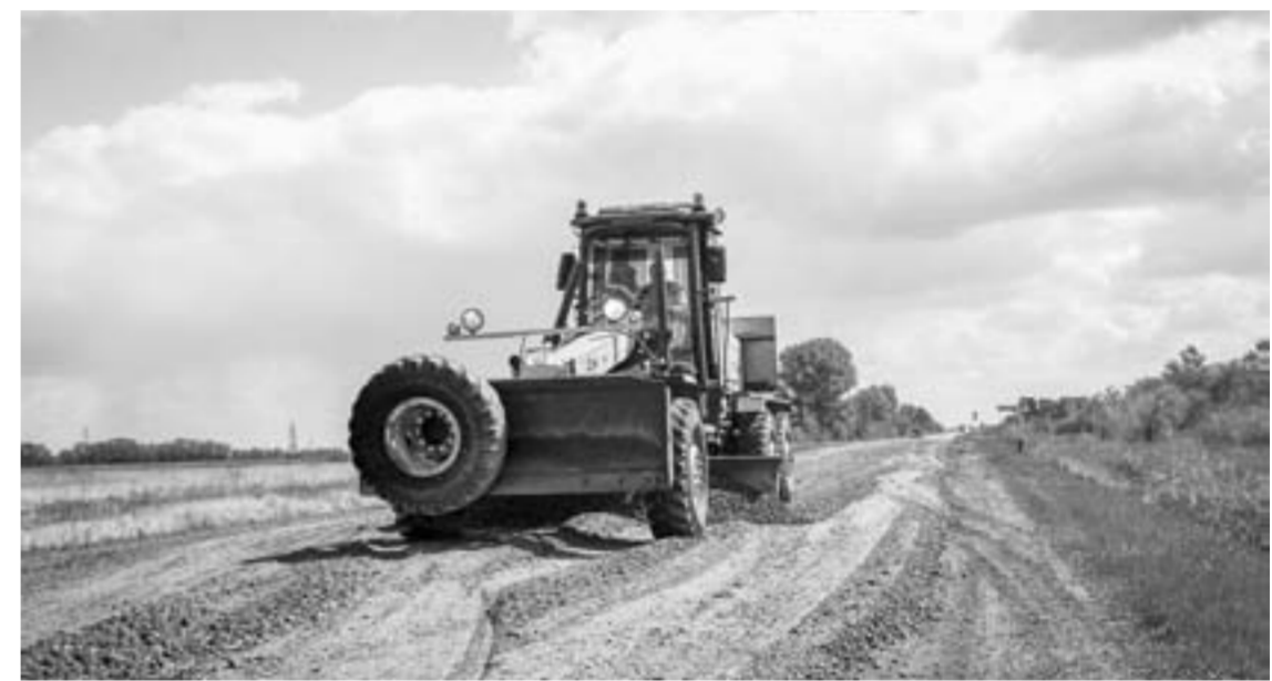
Ведутся работы по исправлению профиля основания.
