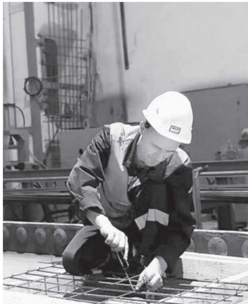
Сборка арматуры – один из важнейших этапов в работе.
