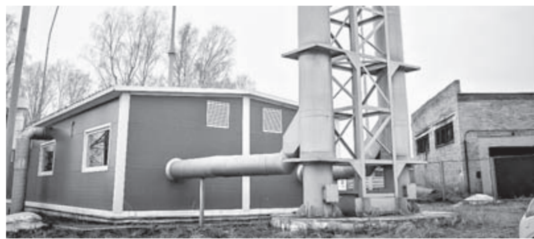
Модульную котельную построили рядом со старой кочеварной.
