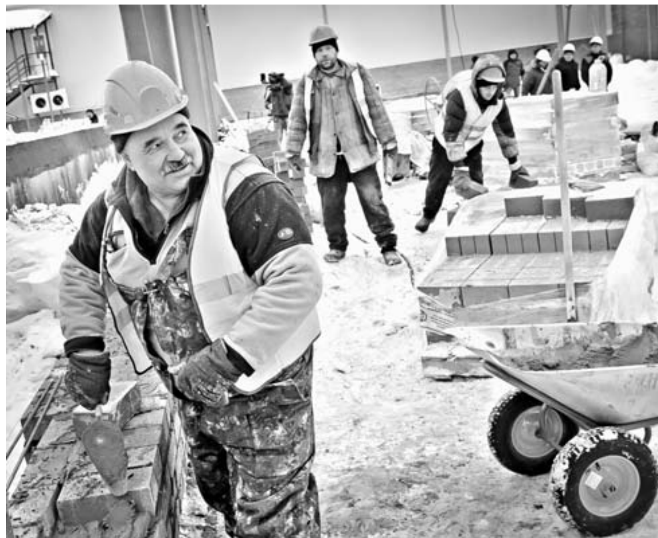
Строители зашли на объект в прошлом году.
