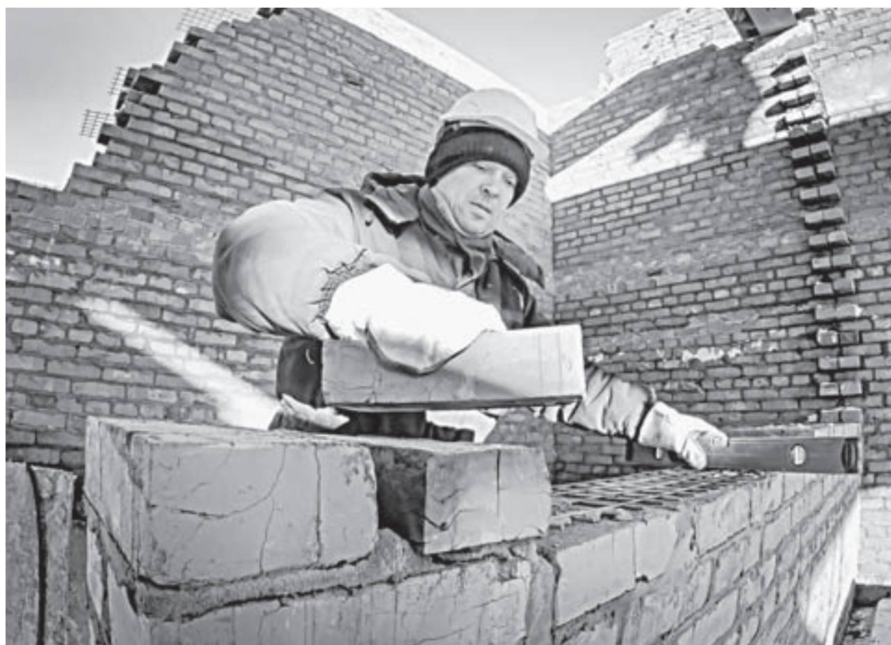
Даже в сильный мороз строители не прекращают работу.
