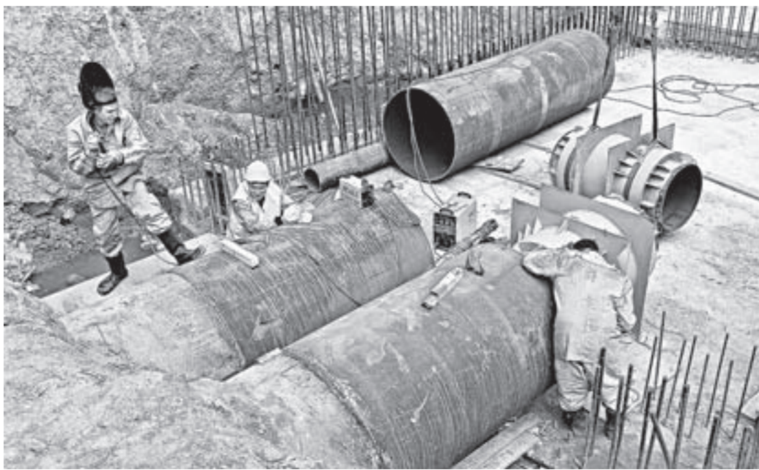
Работы на теплотрассах нужно проводить до наступления холодов.
