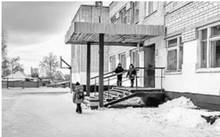
В котельной школы №2 прошел ремонт.
